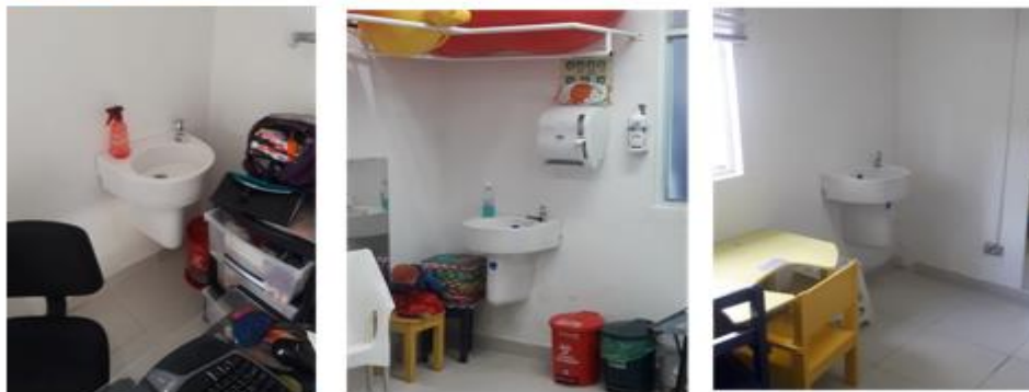
Instalación de lavamanos en Consultorios (6)
